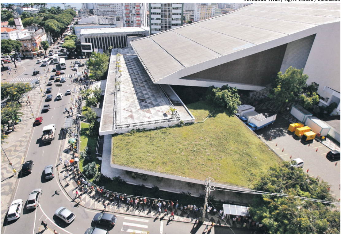
O Castro Alves é o segundo prédio moderno de Salvador a ser tombado pelo Iphan
