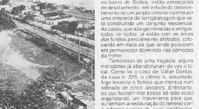
Seis casas da Rua Castro Neves, no bairro de Brotas, estão ameaçadas de desabamento, em virtude do desvelamento de um amplo terreno vizinho por uma empresa local, que atualmente está construindo um conjunto residencial.
