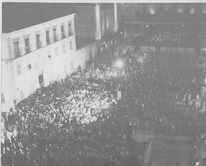
Um grande público compareceu à Praça da Sé, que foi reinaugurada após ter passado por obras de modernização e restauração
